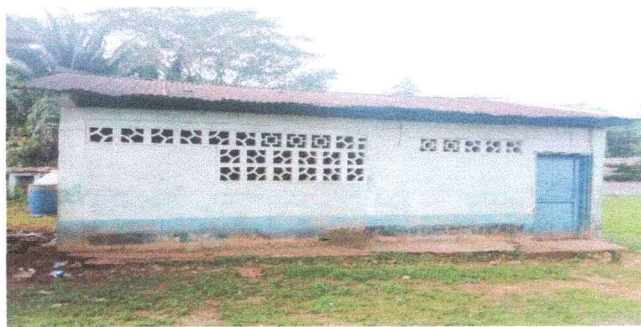
Foto: La fotografía evidencia el cambio del entechado de la estructura completa de la cocina del Establecimiento.
