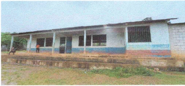
Foto 1: La fotografía evidencia el cambio del entechado de la estructura completa.
